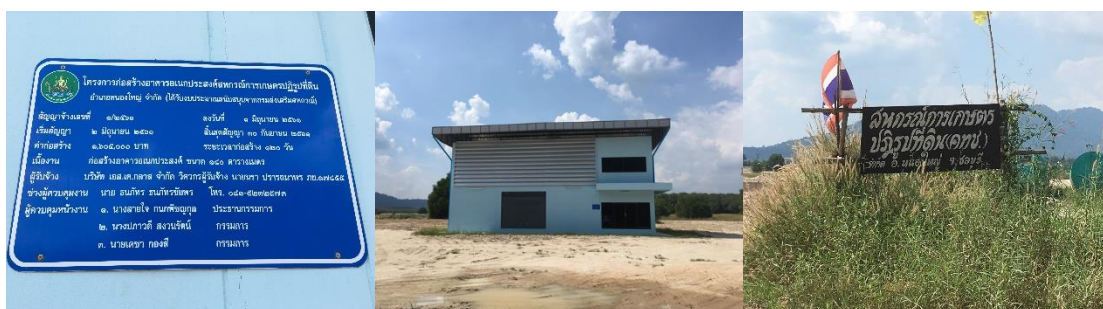
ภาพที่ 8 อาคารสหกรณ์การเกษตรปฎิรูปที่ดินอำเภอหนองใหญ่ (คทช.) จำกัด
