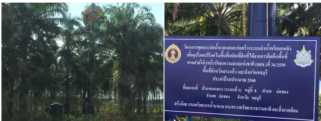
ภาพที่ 15 บ่อบาดาลและระบบกระจายน้ำของพื้นที่สหกรณ์การเกษตรปฎิรูปที่ดิน อำเภอบ่อทอง (คทช.) จำกัด
