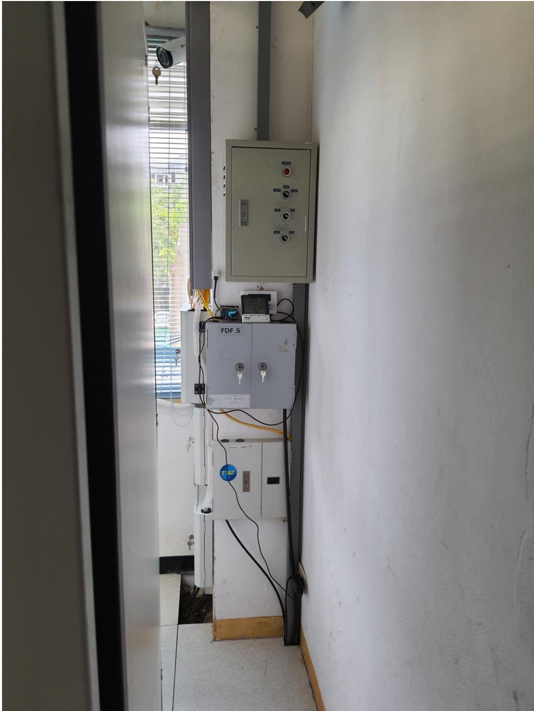
ภาพที่ 4.1 การติดตั้ง IoT Device ที่มีเซ็นเซอร์ DHT
