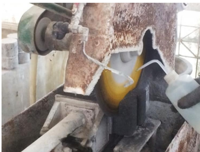
รูปที่ 3.18 การตัดคอนกรีตบล็อก
