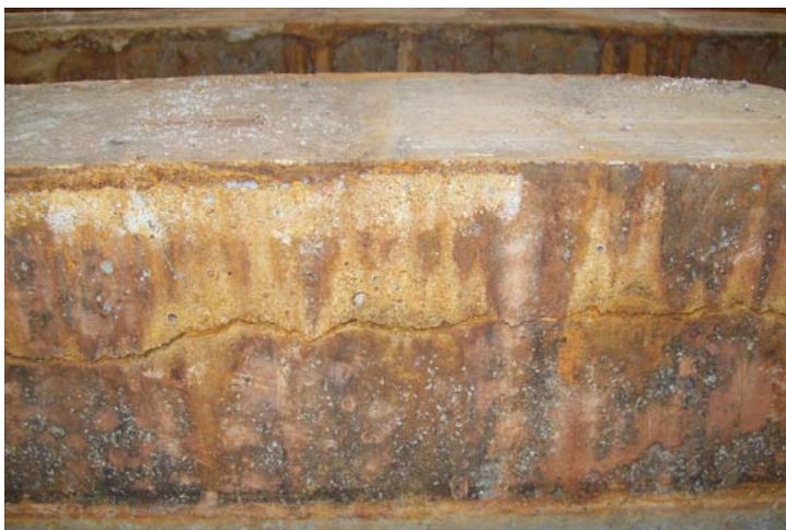
รูปที่ 4.4 รอยร้าวที่เกิดขึ้นของคานค.ส.ล. ที่ความเสียหายระดับต่ำ
