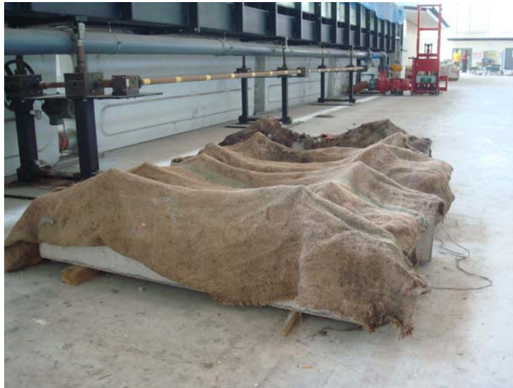
รูปที่ 3.11 การบ่มคานคอนกรีต
