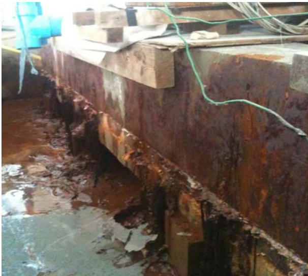
รูปที่ 4.5 รอยร้าวที่เกิดขึ้นของคานค.ส.ล. ที่ความเสียหายระดับปานกลาง
