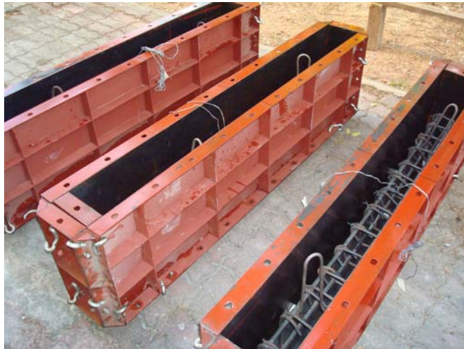
รูปที่ 3.10 การเข้าแบบเหล็กและวิธีการหล่อคาน ค.ส.ล.
