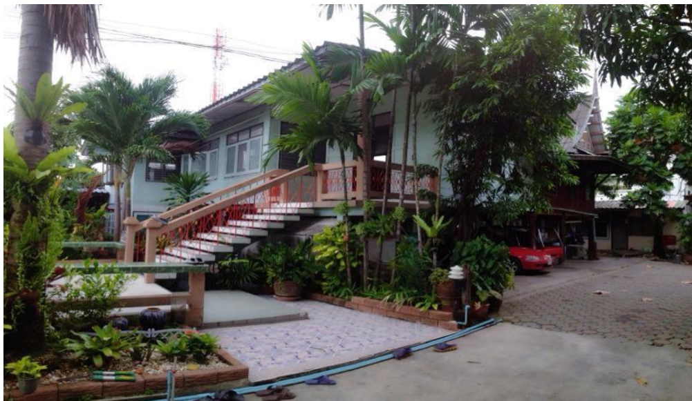
ภาพที่ 5-1 ลักษณะของบ้านไม้ในพื้นที่เขตคลองสามวา ที่มีลักษณะครึ่งไม้ครึ่งปูนส่วนชั้นบน มีอายุกว่า 70 ปี แต่มีการต่อเติมเป็นปูนด้านล่าง
