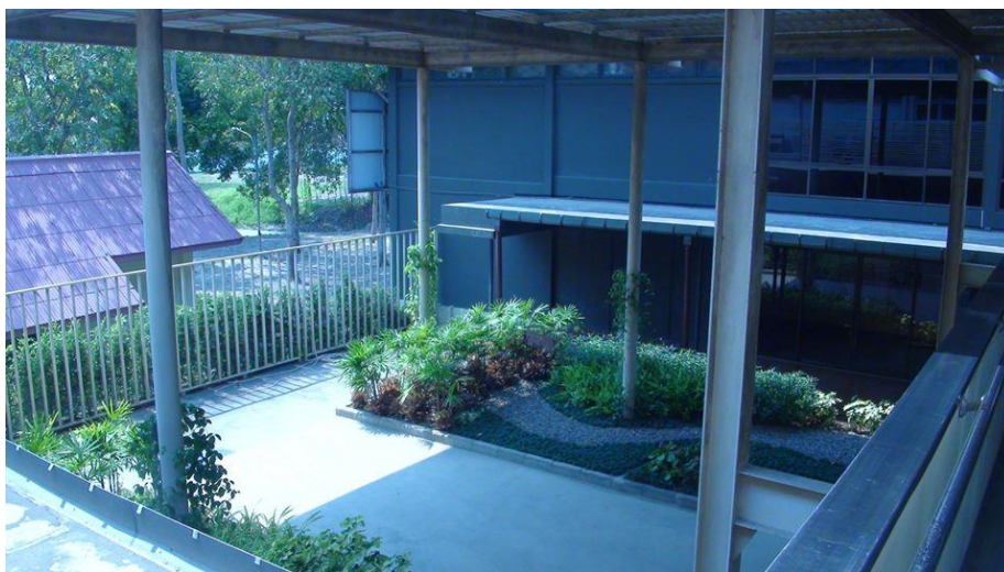
ภาพที่ 5-6 พื้นที่ระหว่างกลาง 2 อาคารของพิพิธภัณฑสถานแห่งชาติ อุทอง
