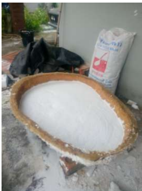
ภาพที่ 3-67 เทปูนพลาสติกปิดทับโครงเหล็กเส้นทั้งหมด
