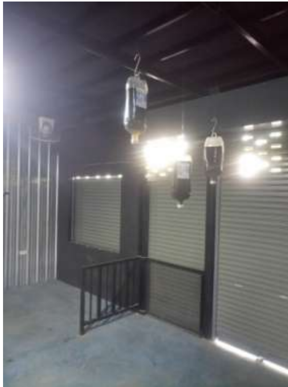
ภาพที่ 3-87 ทดลองแขวนถุงน้ำเกลือโดยการห้อยลงมาจากคาน
