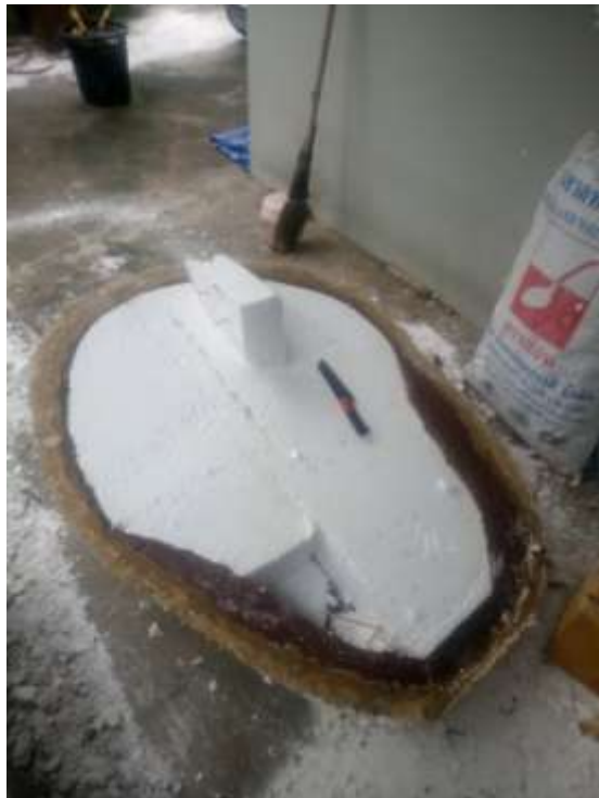
ภาพที่ 3-64 ขั้นตอนการนำโครงสร้างภายในออก
