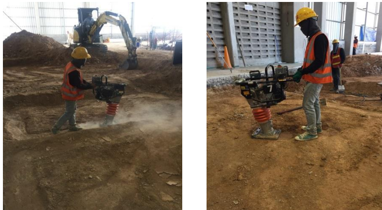
ภาพที่ 2-4 การบดอัดดินด้วยเครื่องตบดินแบบกระโดด ที่มา: ไทยเพนตา-โอเชียน (2559)
