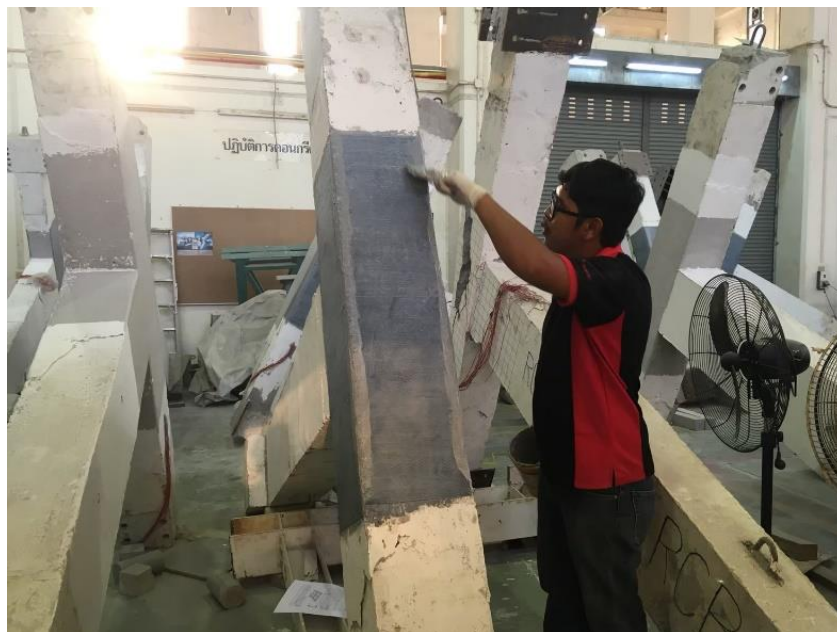
รูปที่ 3.16 การเตรียมผิวคอนกรีตก่อนทาสีประสานและการทาสีประสาน
