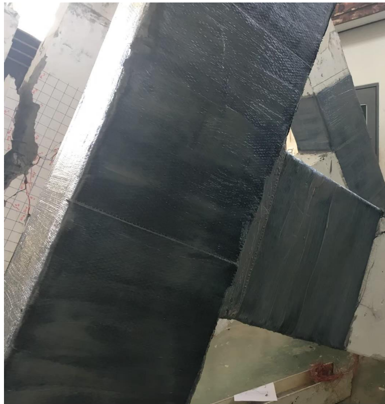
รูปที่ 3.17 การติดตั้งแผ่นไฟเบอร์เสริมกำลัง
