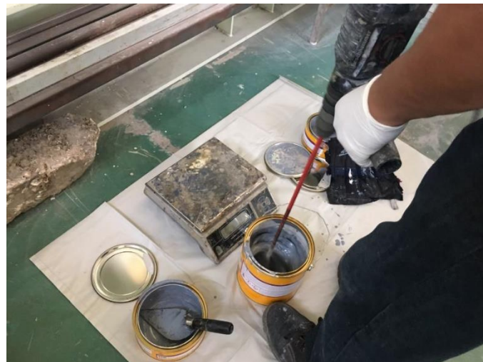
รูปที่ 3.15 การเตรียมวัสดุประสานผิวคอนกรีตและแผ่นไฟเบอร์
