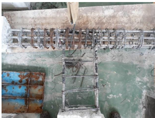
รูปที่ 3.9 คัดเหล็กปลอกที่เสียหายออก
