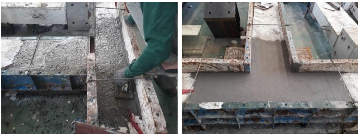
รูปที่ 3.13 แต่งผิวหน้าคอนกรีต
