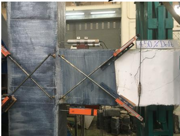
ความเสียหายตัวอย่าง J9R เมื่อแผ่นไฟเบอร์เริ่มฉีกขาด
