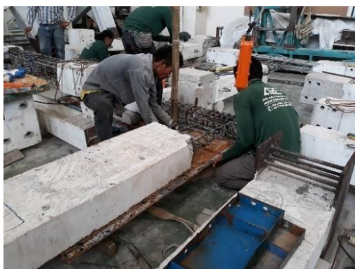
รูปที่ 3.11 เข้าแบบหล่อคอนกรีต
