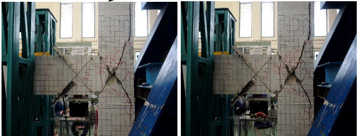
ความเสียหายตัวอย่าง J9 ที่เห็นเหล็กเสริม
