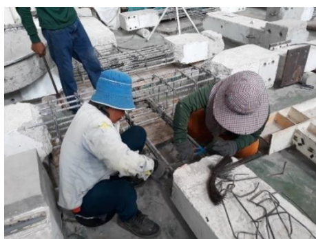
รูปที่ 3.9 คัดเหล็กปลอกที่เสียหายออก
