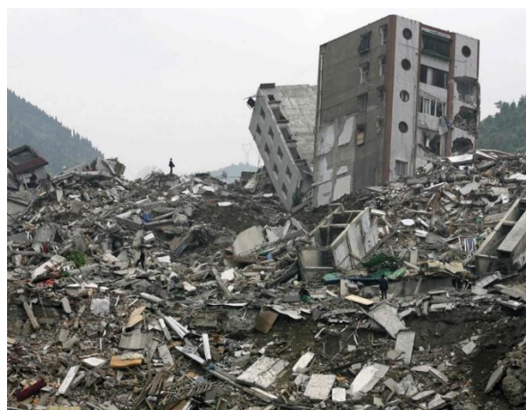
รูปที่ 1.2 ความเสียหายของอาคารคอนกรีตเหล็กภายหลังการเกิดแผ่นดินไหว
