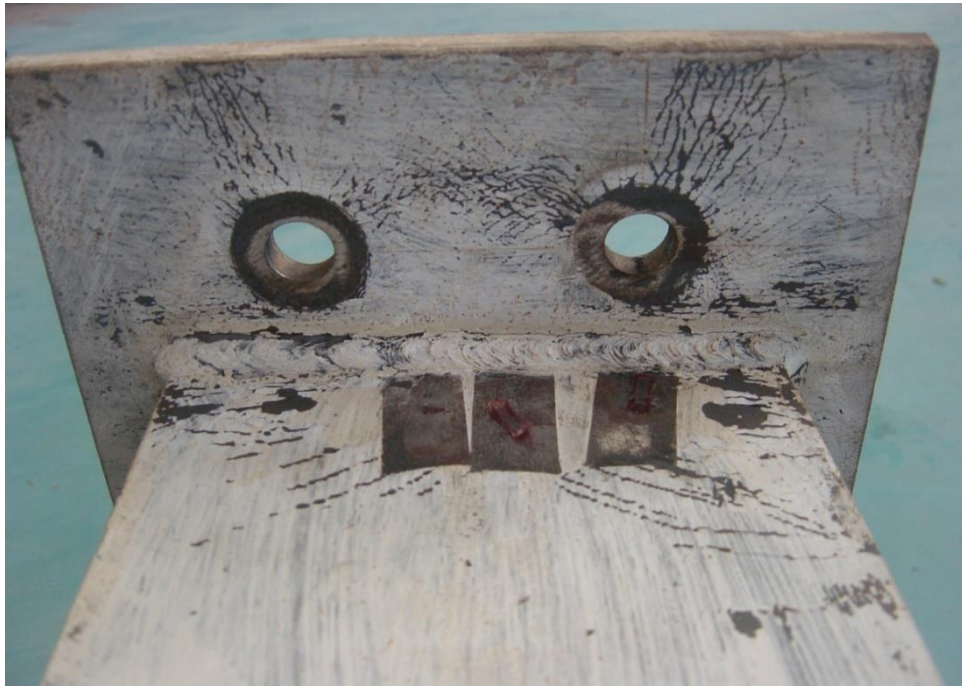
รูปที่ 4.6 การครากที่บริเวณแผ่นปีกบนของคาน และเพลทระหว่างหน้าเสากับปลายคาน SP1
