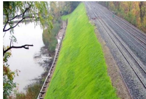
(ข) ลาดดินทางรถไฟ
