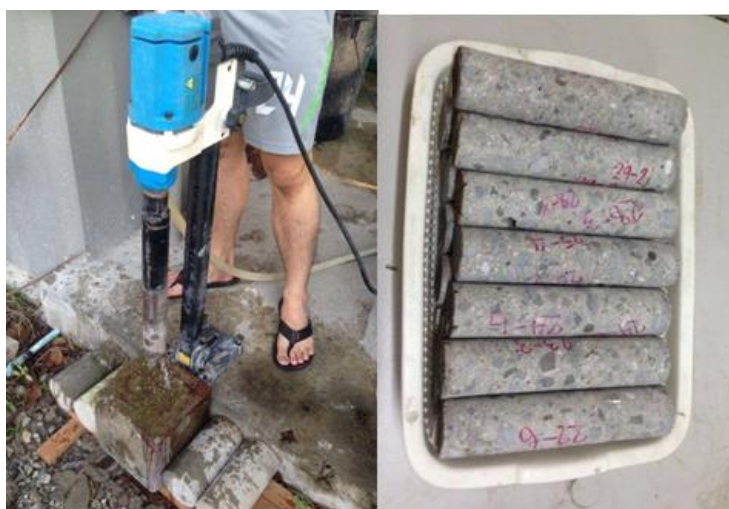
รูปที่ 3.4 การเจาะตัวอย่างคอนกรีต
