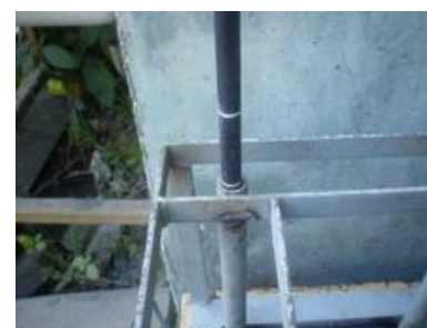
(ง) ตรวจสอบว่าเหล็กที่ฝิ่งอยู่ในตำแหน่งที่ต้องการ
