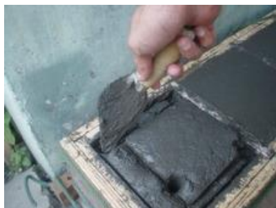
(จ) ใช้เกรียงเกลี่ยคอนกรีตสดให้เต็มแบบหล่อ
