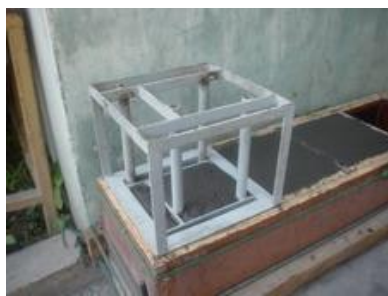
(ก) วางแบบฝิ่งเหล็กบนแบบหล่อคอนกรีต
