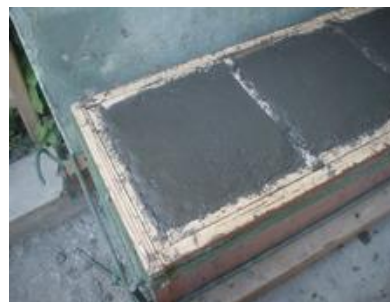
(ฉ) ตกแต่งผิวหน้าคอนกรีตให้เรียบ
