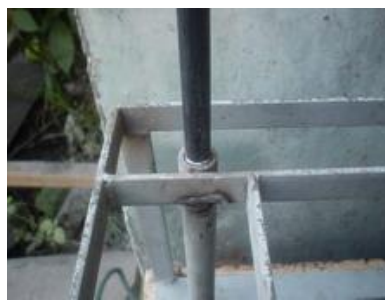
(ข) ใช้เหล็กนำร่องเพื่อดันคอนกรีตให้เกิดช่องว่าง
