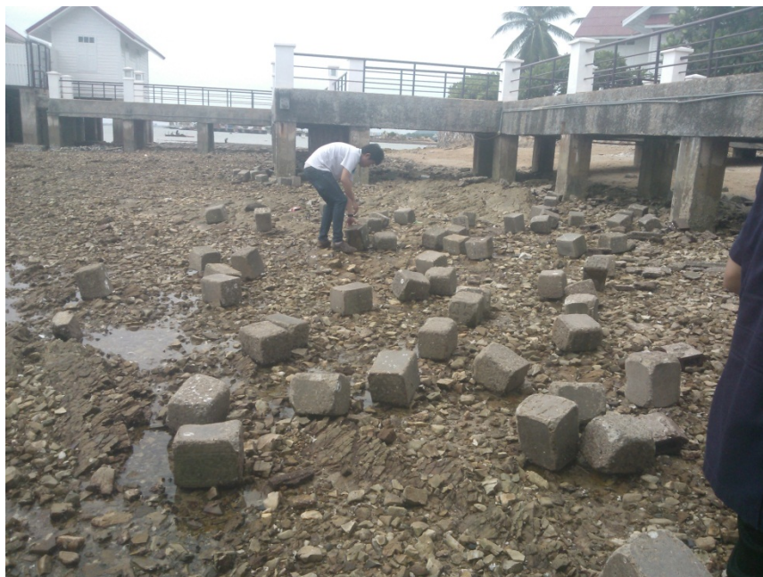
รูปที่ 3.2 สถานที่แช่ตัวอย่างคอนกรีตที่โรงพยาบาลสมเด็จพระบรมราชเทวี อำเภอสรีราชา จังหวัดชลบุรี
