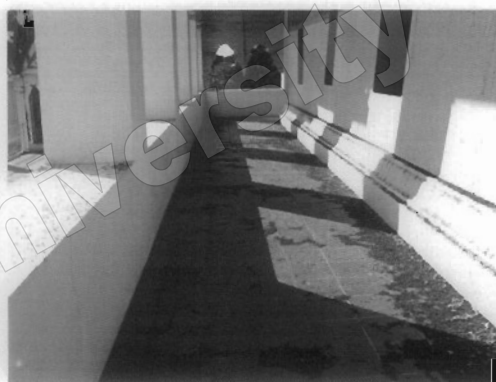
ภาพที่ 4-155 ลัทธิที่มาอาศัยในตัวลิม เช่น นก ค้างคาว ถ่ายมูลทิ้งไว้ทำให้ stupādām เสียหาย
