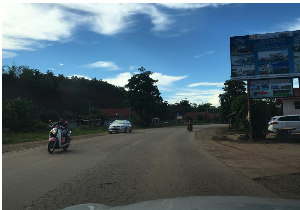
ภาพที่ 4-14 เส้นทาง R3A ในสปป.ลาว เติรรถถนนเลนขวา สภาพถนนขาดการซ่อมแซม
