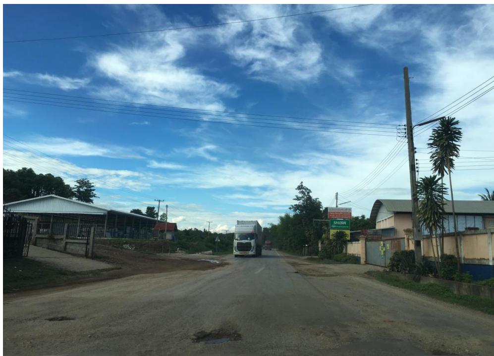
ภาพที่ 4-15 เส้นทาง R3A ในสปป.ลาว ขนาดรถบรรทุกทุกเดินทาง สภาพถนนค่อนข้างชำรุด เป็นหลุม ลึก
