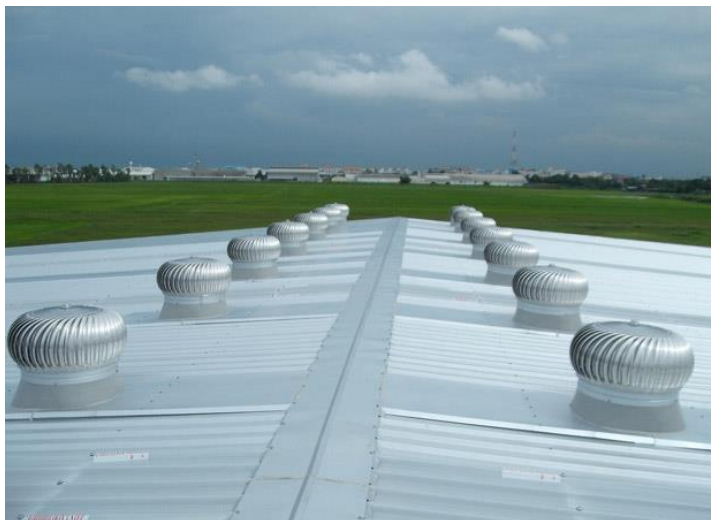
ภาพที่ 2-8 ลูกหมุนระบายอากาศ (บริษัทเอสที เมทัลรูฟ จำกัด, 2557)
