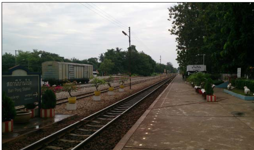
ภาพที่ 2-7 สถานีรถไฟบ้านโป่ง เส้นทางมุ่งหน้าสู่ภาคใต้
