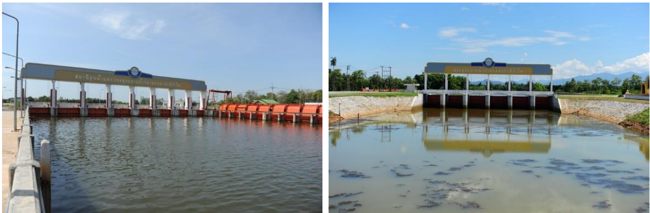
ภาพที่ 4-27 ประตูระบายน้ำบริเวณเมืองจันทบุรี จังหวัดจันทบุรี
