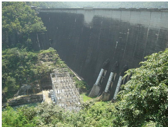
รูปที่ 2.8 การก่อสร้างเขื่อนภูมิพลที่จังหวัดตาก (ปริญา จินดาประเสริฐ, 2547)
