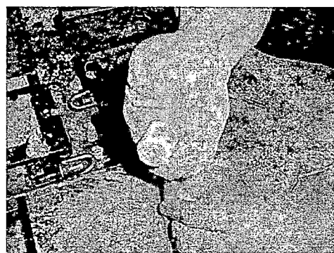
(ข) ฝังกเหล็กตามตำแหน่งที่กำหนด
