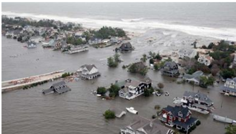
ภาพที่ 2.4 ภาพถ่ายทางอากาศแสดงให้เห็นถึงความเสียหายบริเวณชายฝั่งของมลรัฐนิวเจอร์ซีย์ ประเทศสหรัฐอเมริกา หลังจากเกิดเหตุการณ์ Superstorm Sandy เมื่อวันที่ 30 ตุลาคม 2555 (Olsen, 2018)
