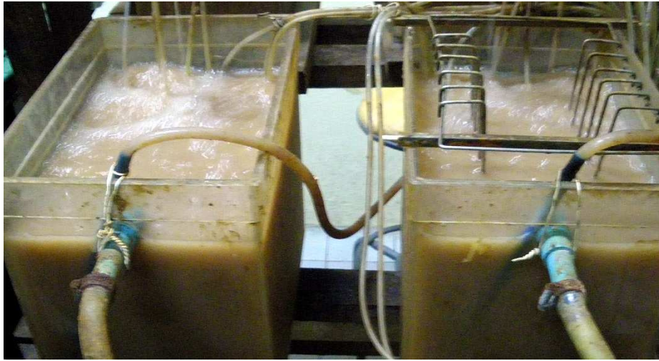
ภาพที่ 6 ถังปฏิกิริยาเติมอากาศของระบบบำบัดน้ำเสีย IFAS 1 และ IFAS 2
