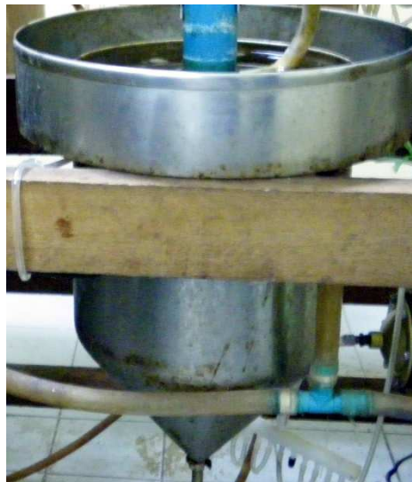
ภาพที่ 7 ถังตกตะกอนของระบบบำบัดน้ำเสีย IFAS 1 และ IFAS 2
