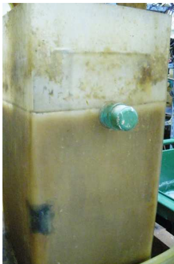
ภาพที่ 5 ถังปฏิกริยาแอนนออกซิกของระบบบำบัดน้ำเสีย IFAS 1 ที่มีการติดตั้งตัวกลาง
