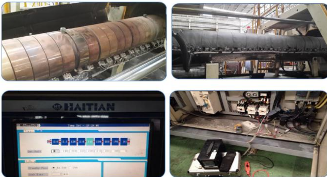
ภาพที่ 4-45 ตัวอย่างการติดตั้ง Insulator
