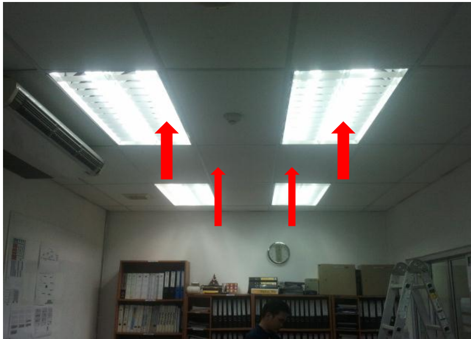
ภาพที่ 4-48 การทดลองติดตั้งหลอดไฟจำนวน 8 หลอด
